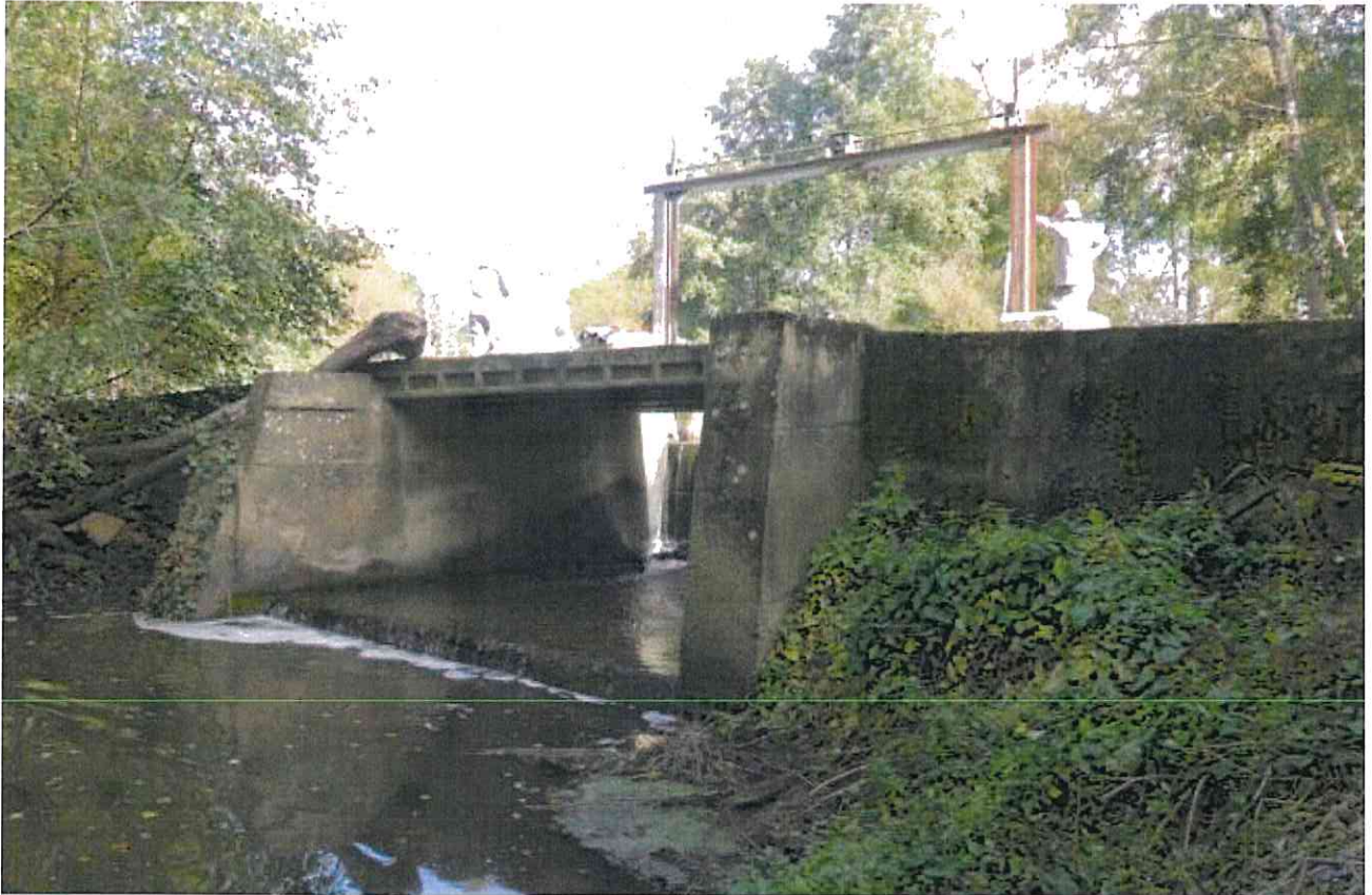
Vue de l'ouvrage depuis l'aval de la vanne guillotine (rive gauche)
